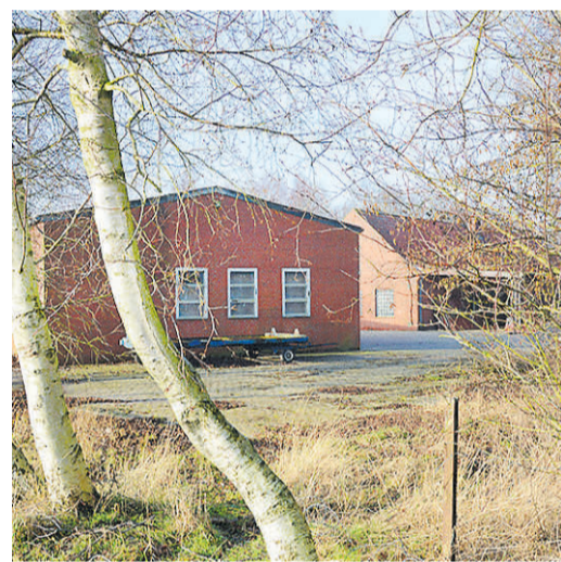
Die Gebäude des ehemaligen Bauamtes für Küstenschutz sollen in den Hotelkomplex integriert werden.
